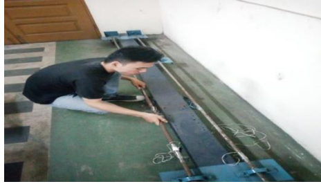
Gambar 3.29 Pemasangan Striker Bar
