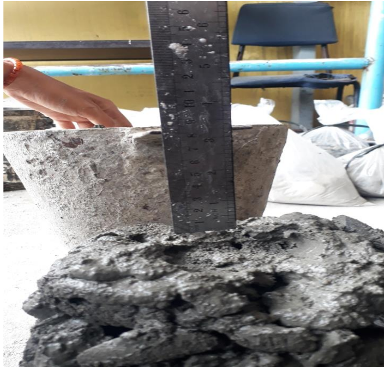
Gambar L5: Dokumentasi proses pengecoran pembuatan benda uji penelitian
