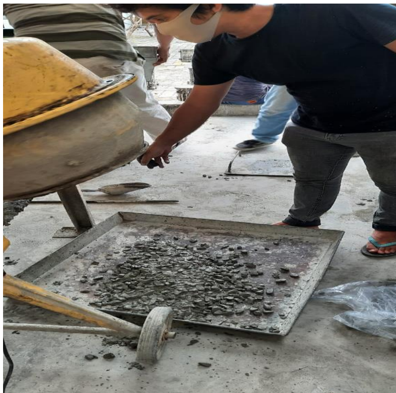
Gambar L4: Dokumentasi proses pengecoran pembuatan benda uji penelitian
