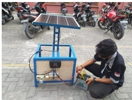
Gambar 3.27 Memasang Baterai
