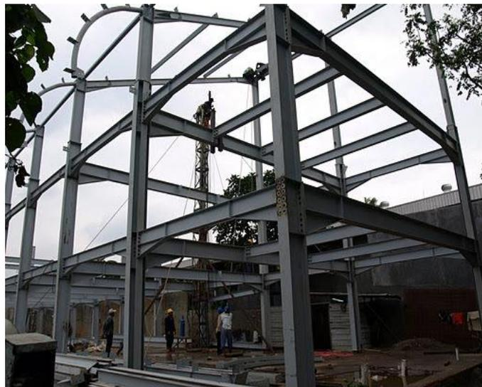
Gambar 2.2: Rangka portal menggunakan balok profil IWF.
