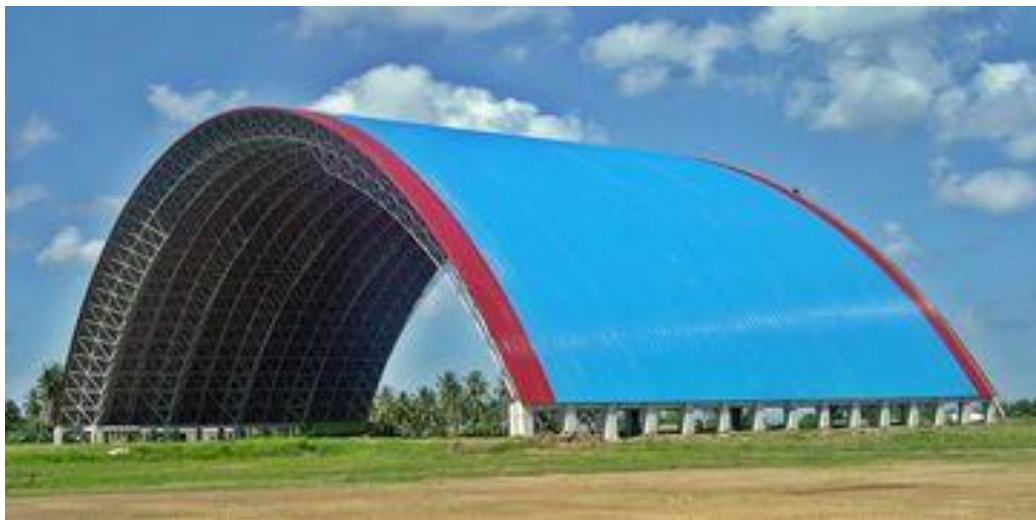
Gambar 2.6: Coal Shed PLTU Tanjung Selaki Lampung .
