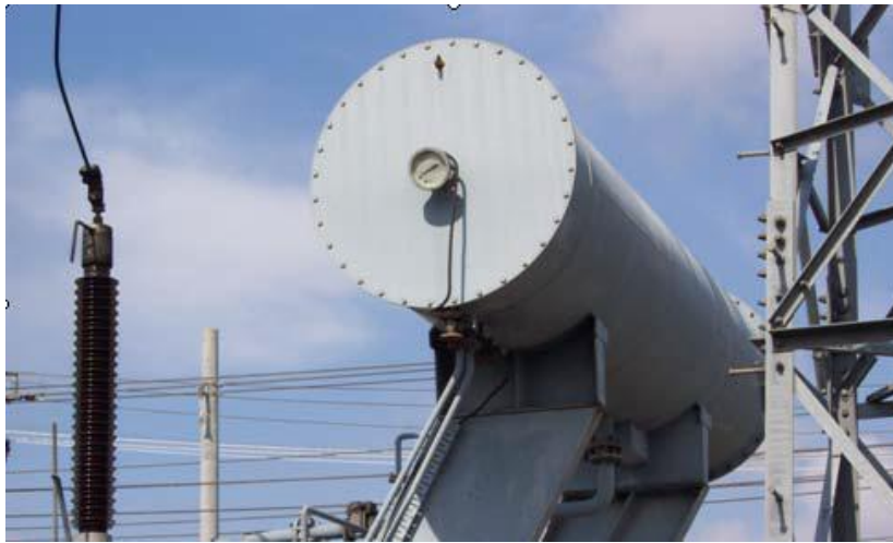
Gambar 2.7 Konservator Minyak Transformator
