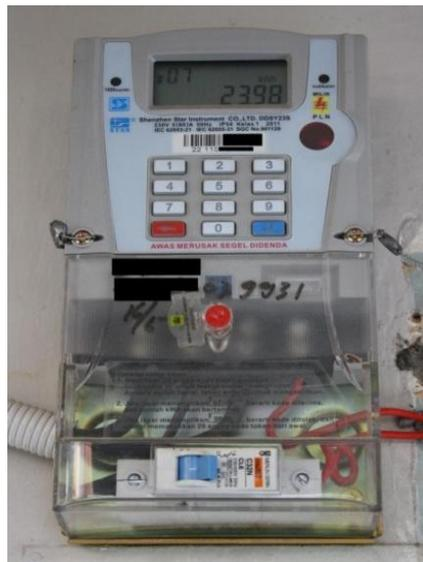
Gambar 2.15 : kWh meter digital
