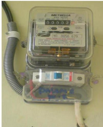
Gambar 2.14 : kWh meter analog
