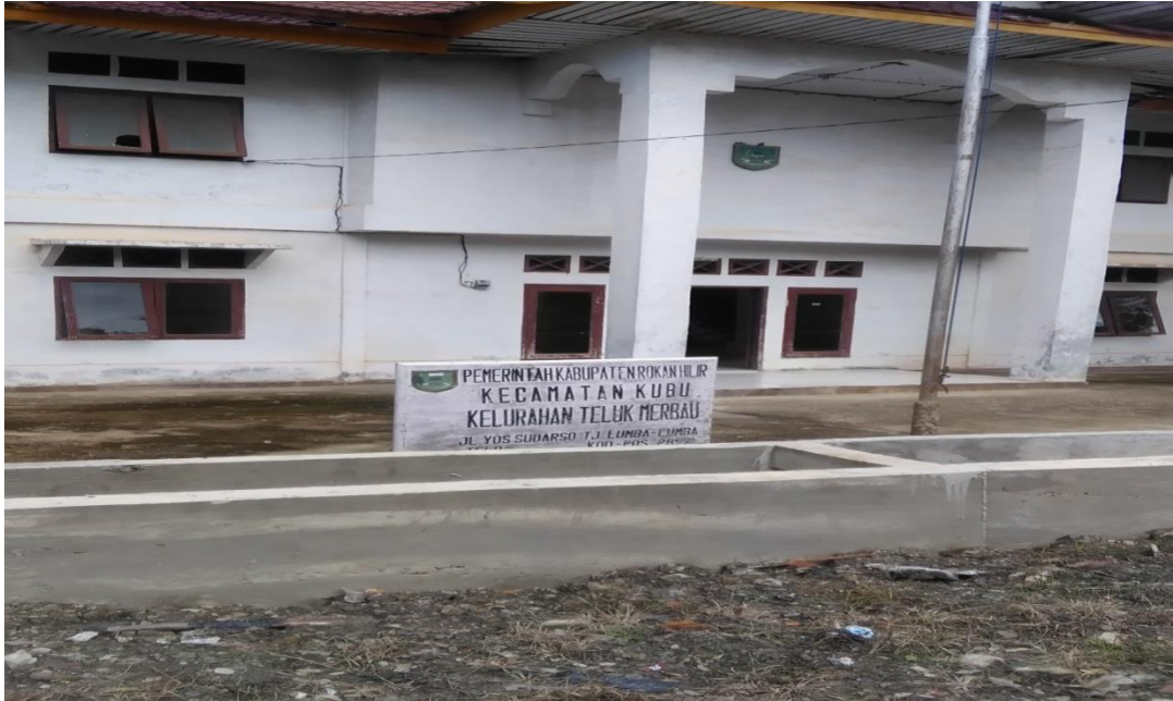
Kantor Kecamatan Kubu Kelurahan Teluk Merbau
