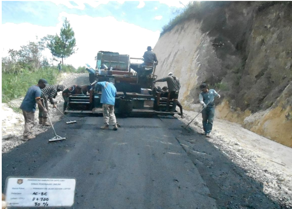
Gambar L5: Laston lapis antara (AC-BC)
