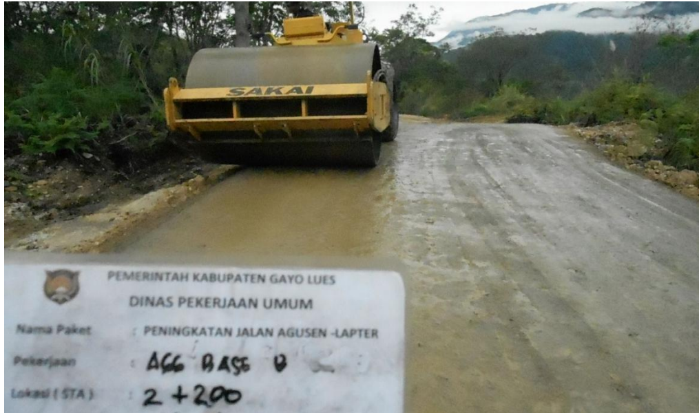
Gambar L1: Pemasangan agregat kelas B.
