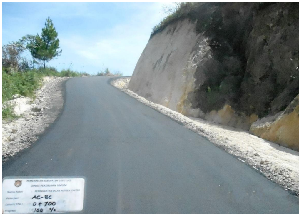
Gambar L8: Lapisan perkerasan AC-BC
