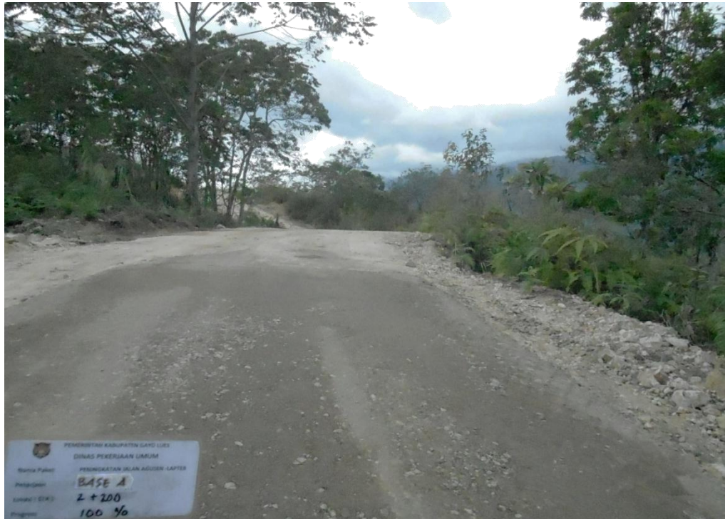
Gambar L3. Lapisan agregat kelas A
