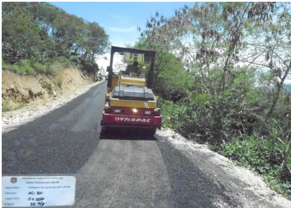
Gambar L5: Laston lapis antara (AC-BC)
