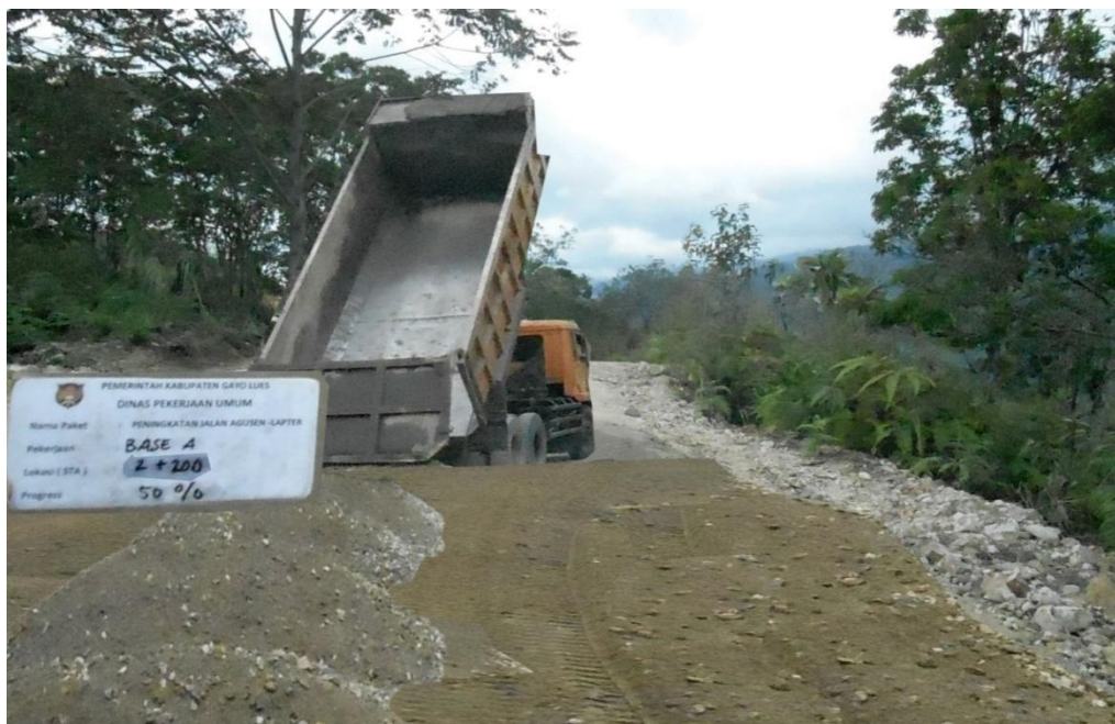
Gambar L2: Penghamparan agregat kelas A.
