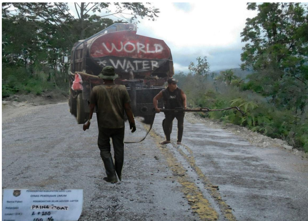
Gambar L4: Lapisan resap pengikat-aspalcair
