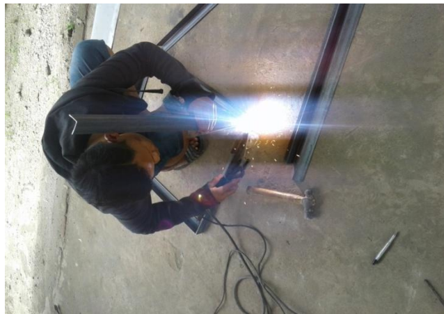
Gambar 3.19. Pengelasan tiang kaki konstruksi
