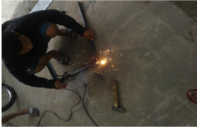
Gambar 3.18. pengelasan konstruksi dudukan penempa hidrolik
