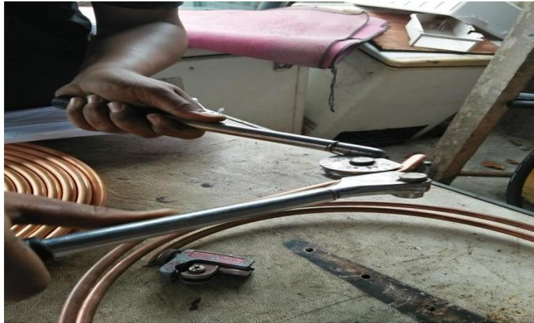
**Gambar 3.24 Pembengkokan Pada Pipa**
