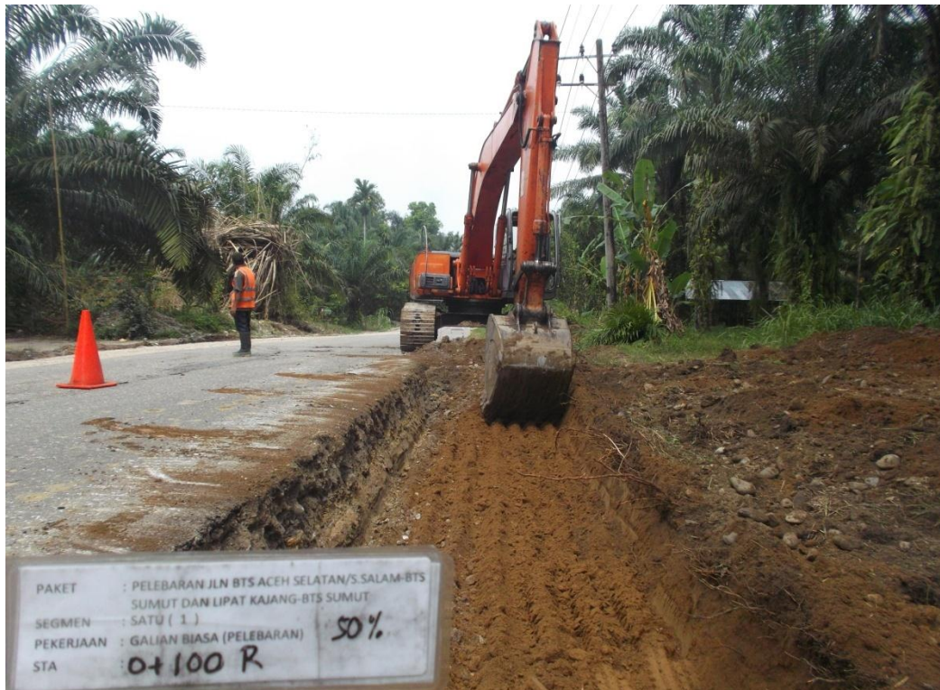
Gambar L 2. Kondisi saat penggalian bahu jalan.
