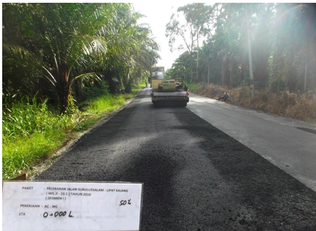
Gambar L13. Perletakan bahan AC-WC dengan tebal 4 cm.
