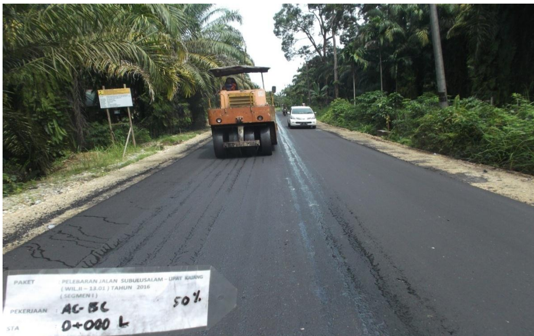
Gambar L12. Perletakan bahan AC-BC dengan tebal 6 cm.
