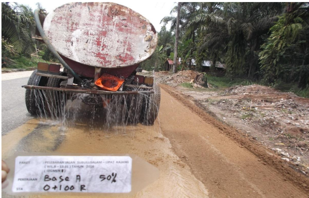
Gambar L6. Peletakan material dan proses pemadatan batu pecah kelas A.
