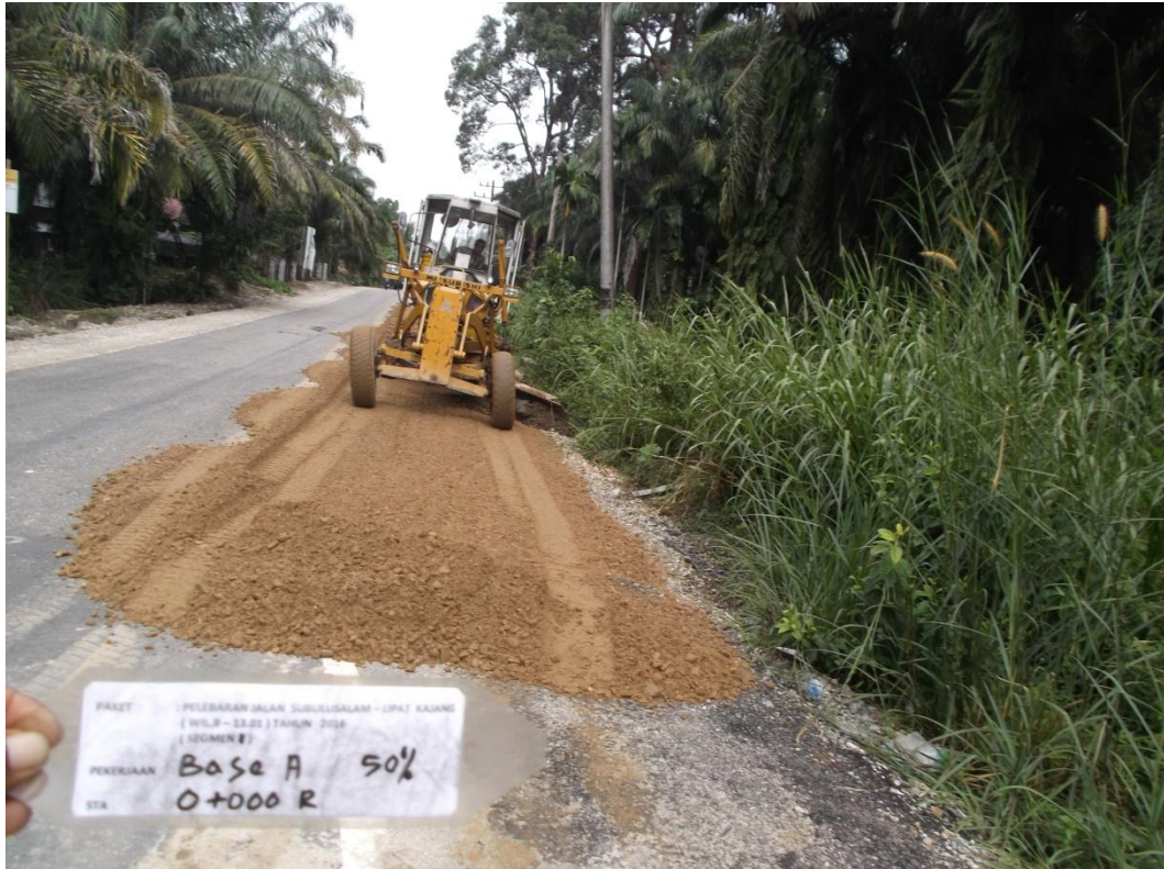
Gambar L5. Peletakan material dan proses pemadatan batu pecah kelas A.
