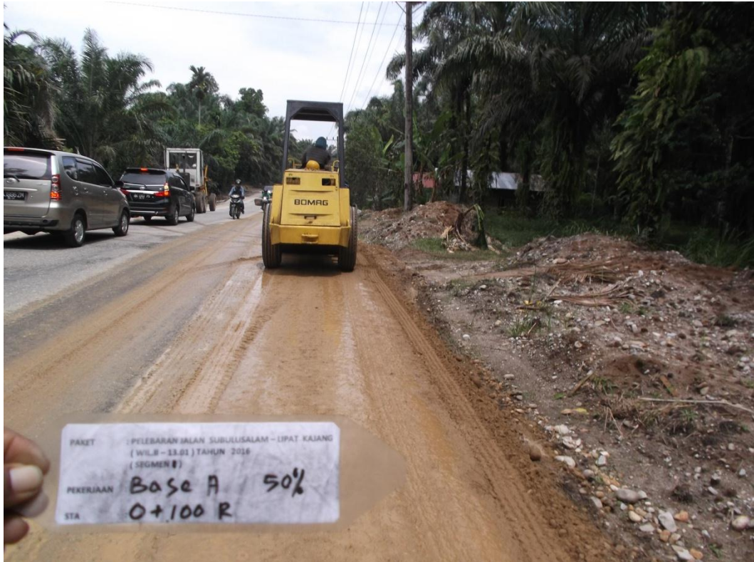
Gambar L7. Peletakan material dan proses pemadatan batu pecah kelas A.
