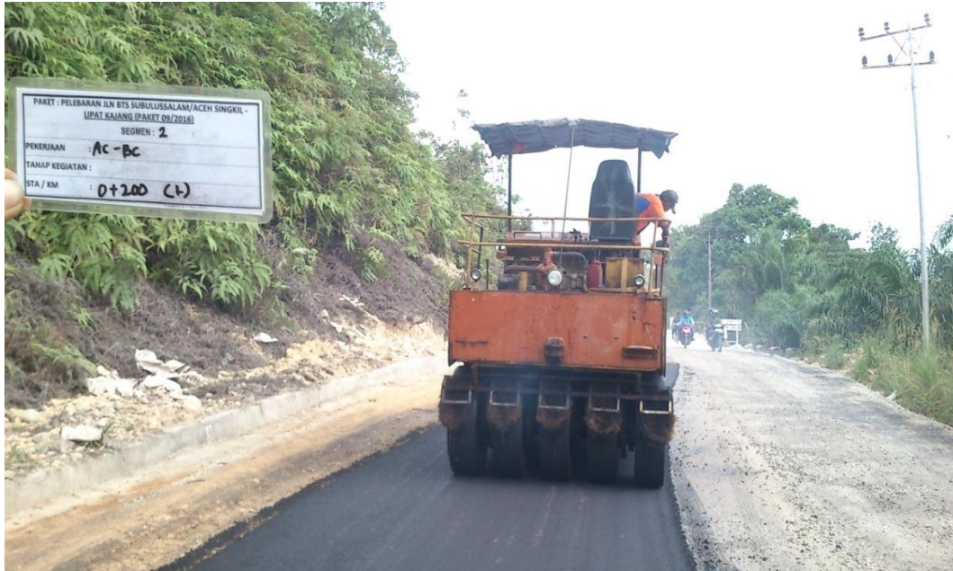
Gambar L11. Perletakan bahan AC-BC dengan tebal 6 cm.
