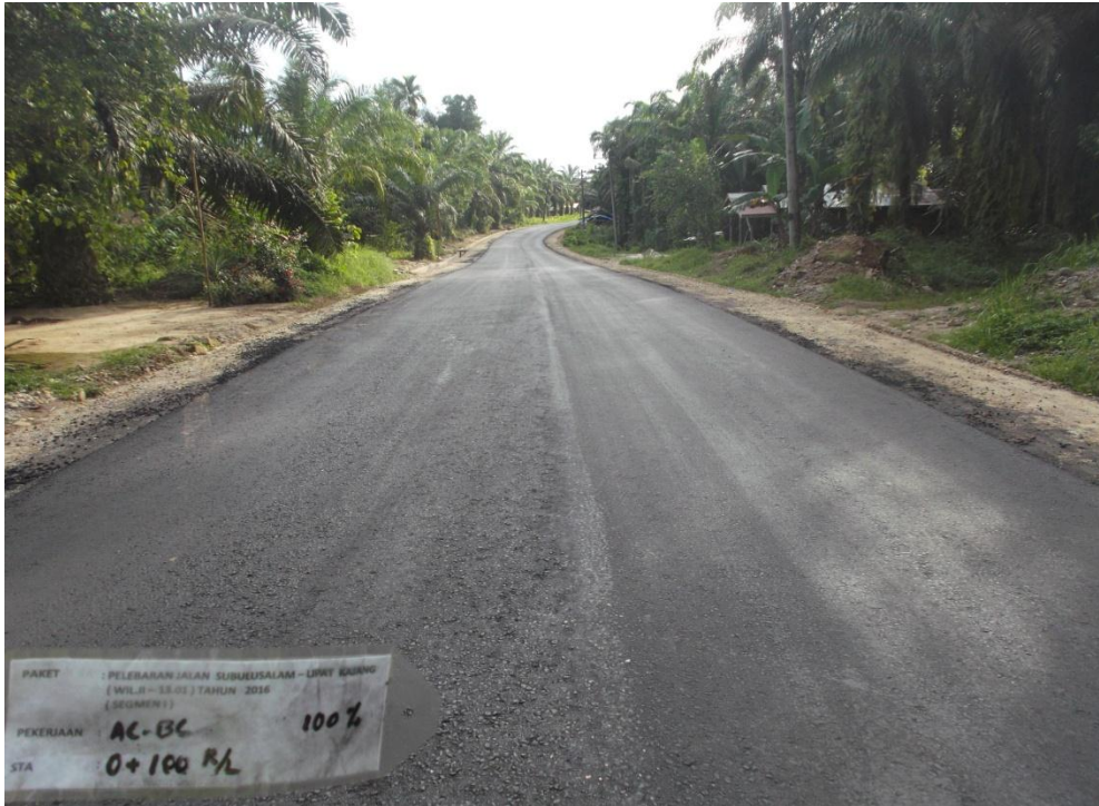
Gambar L15. Perletakan bahan AC-WC dengan tebal 4 cm.
