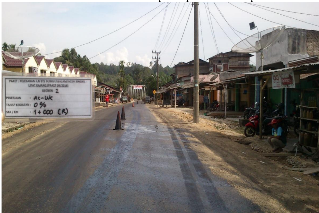
Gambar L8. Penyiraman bahan ikat prime coat.
