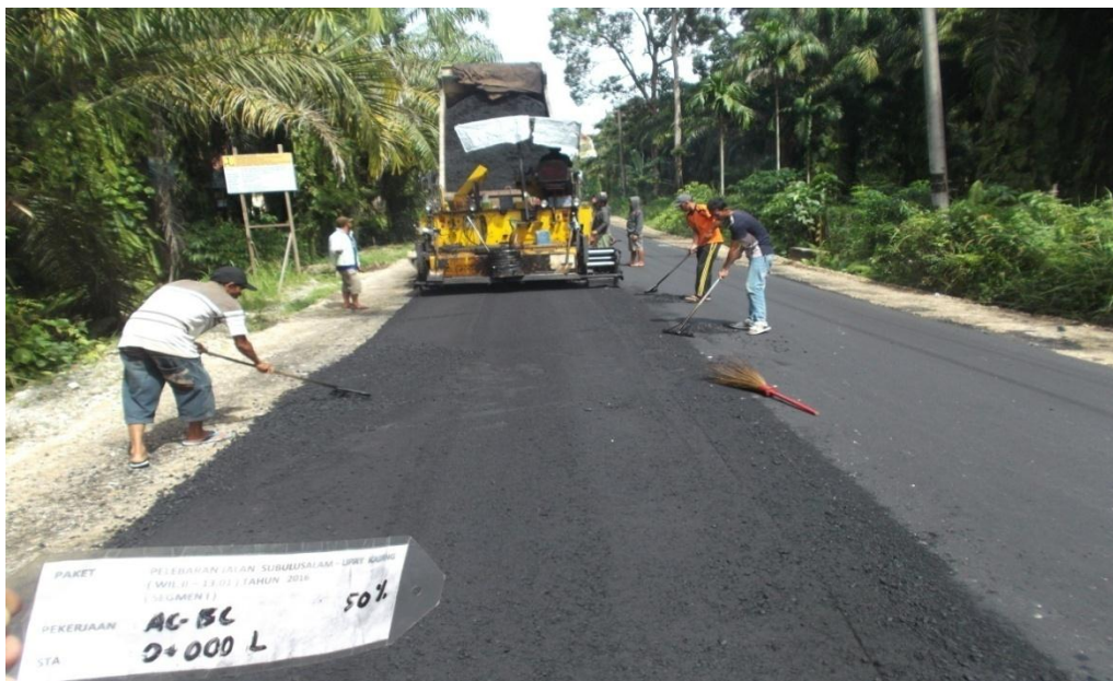
Gambar L10. Perletakan bahan AC-BC dengan tebal 6 cm.
