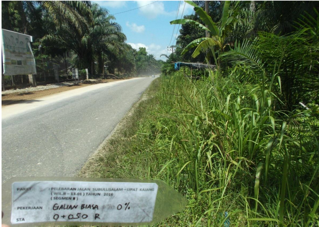
Gambar L1. Kondisi awal sebelum penggalian bahu jalan.
