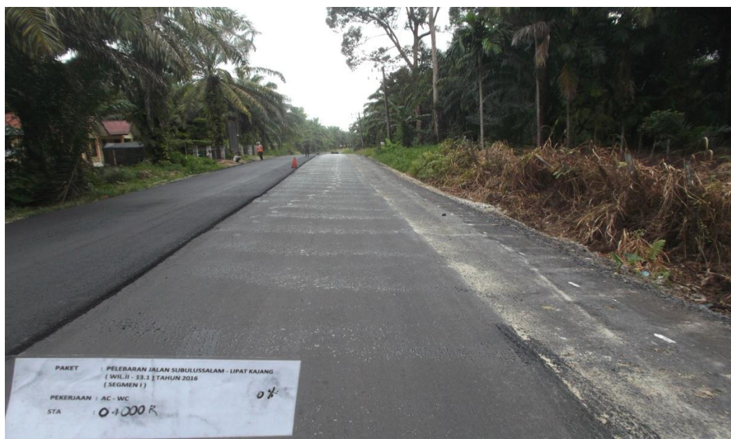
Gambar L14. Perletakan bahan AC-WC dengan tebal 4 cm.
