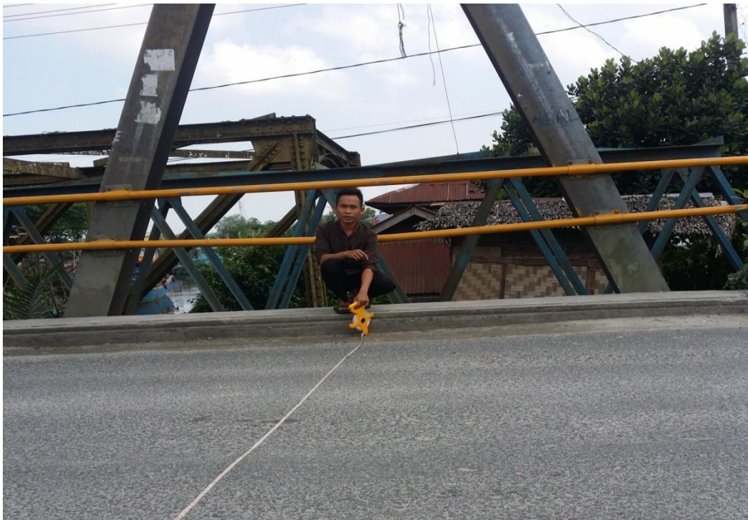
Gambar L3. 8 : Pengukuran lebar badan jembatan.
