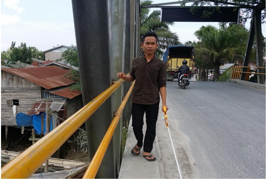
Gambar L3. 7 : Pengukuran panjang jembatan.
