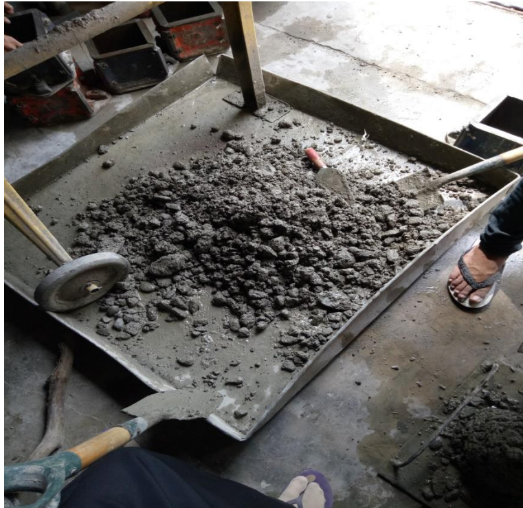
Gambar L7: Proses pengadukan agregat.
