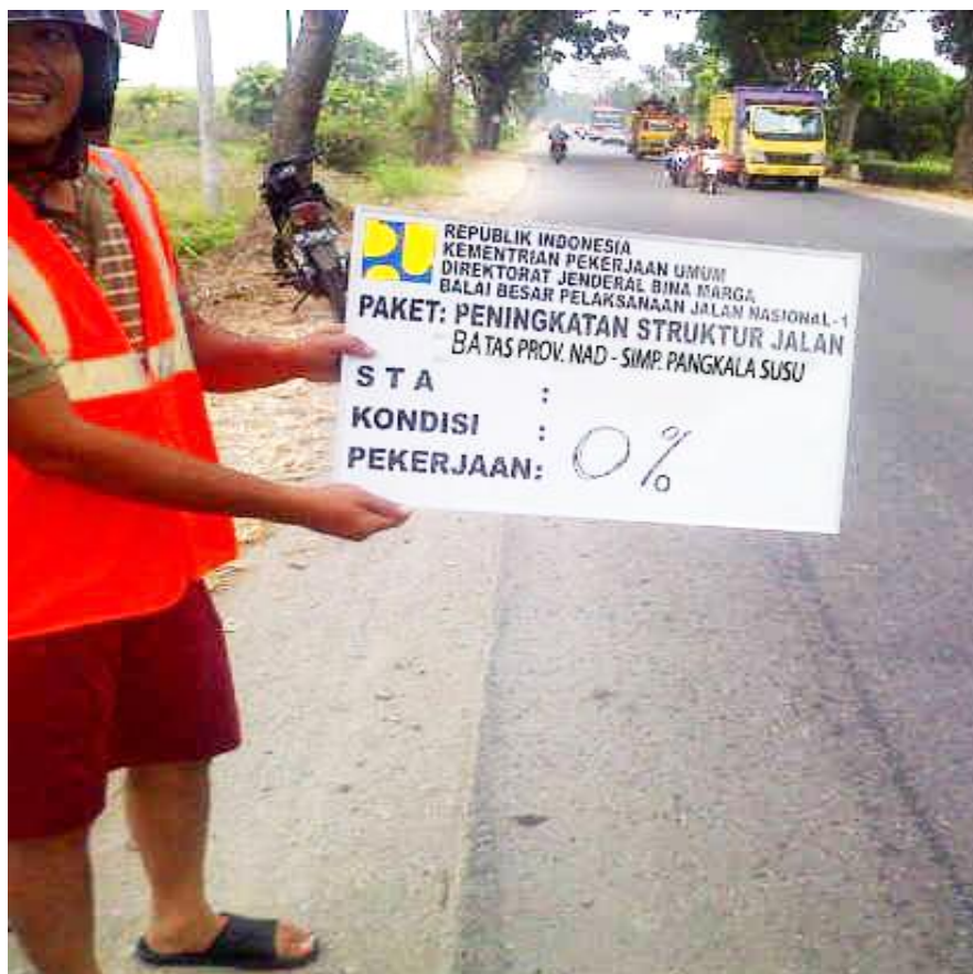
Gambar L1: Kondisi saat Pekerjaan 0%
