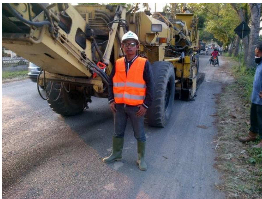
Gambar L2: Pelaksanaan galian perkerasan dengan alat Cold Milling Machine
