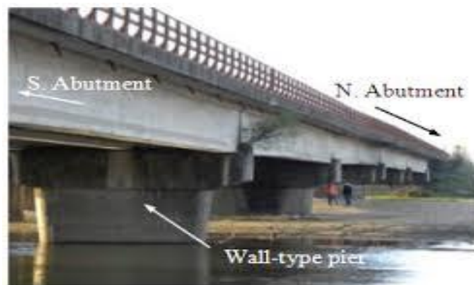
Gambar 2.3: Pilar tipe berdinding penuh pada jembatan ( https://www.fhwa.dot.gov ).
