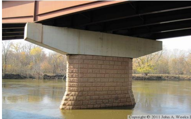
Gambar 2.2: Pilar tipe hammerhead yang ada pada jembatan ( http://civildigital.com ).
