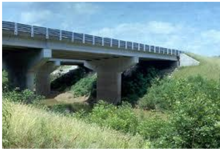
Gambar 2.20: Salah satu pilar hammerhead yang digunakan di kawasan sungai (Chen dkk., 2000).
