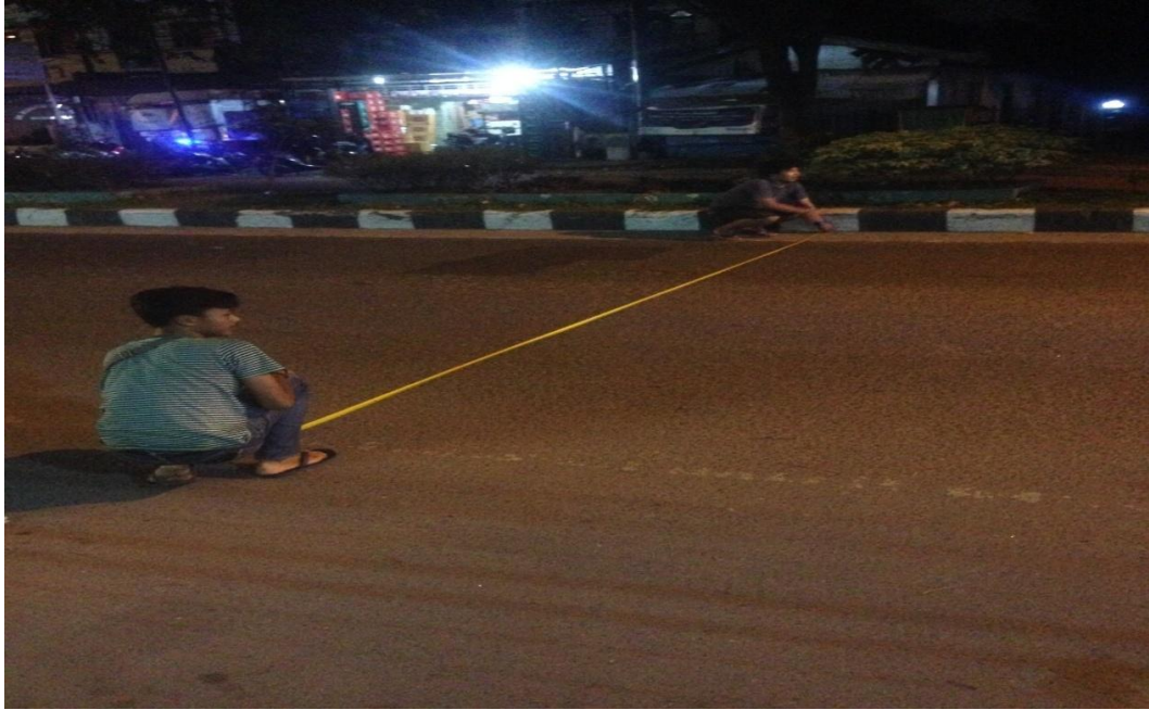
Gambar L1: Mengukur data geometrik jalan.
