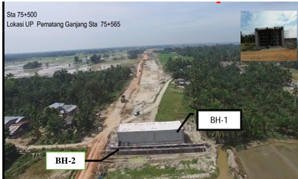
Gambar 3.3: Lokasi titik pengeboran BH-1 Sta 75 +561 dan BH-2 Sta 75 +550 (Dokumentasi PT. Waskita Karya Seksi 6).
