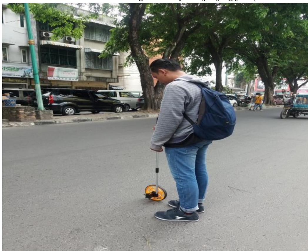
Gambar L.25: Survei geometrik jalan (lebar jalur)
