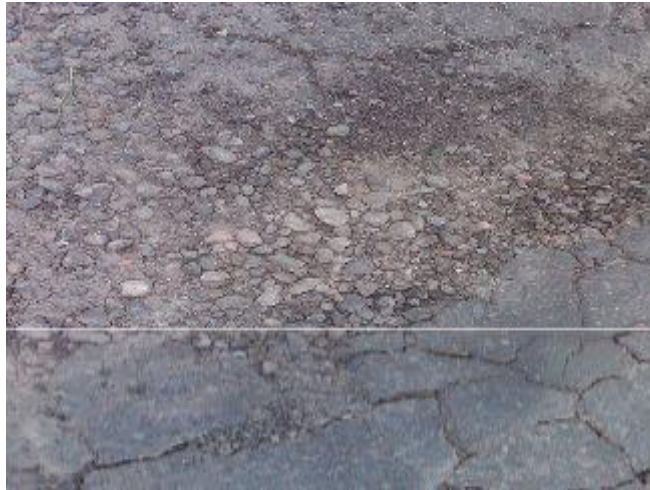
Gambar 2.16: Pelepasan butir ( Raveling ) (SOP PUPR 2016).
