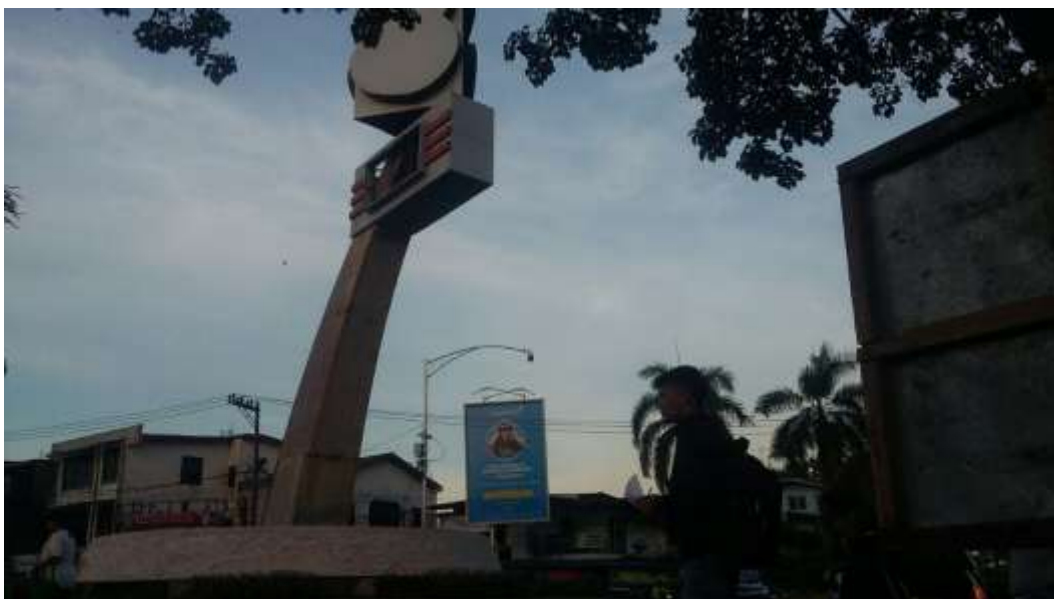
Gambar L.1: Kondisi bundaran jalan Ir. H. Juanda – KH. Samanhudi.
