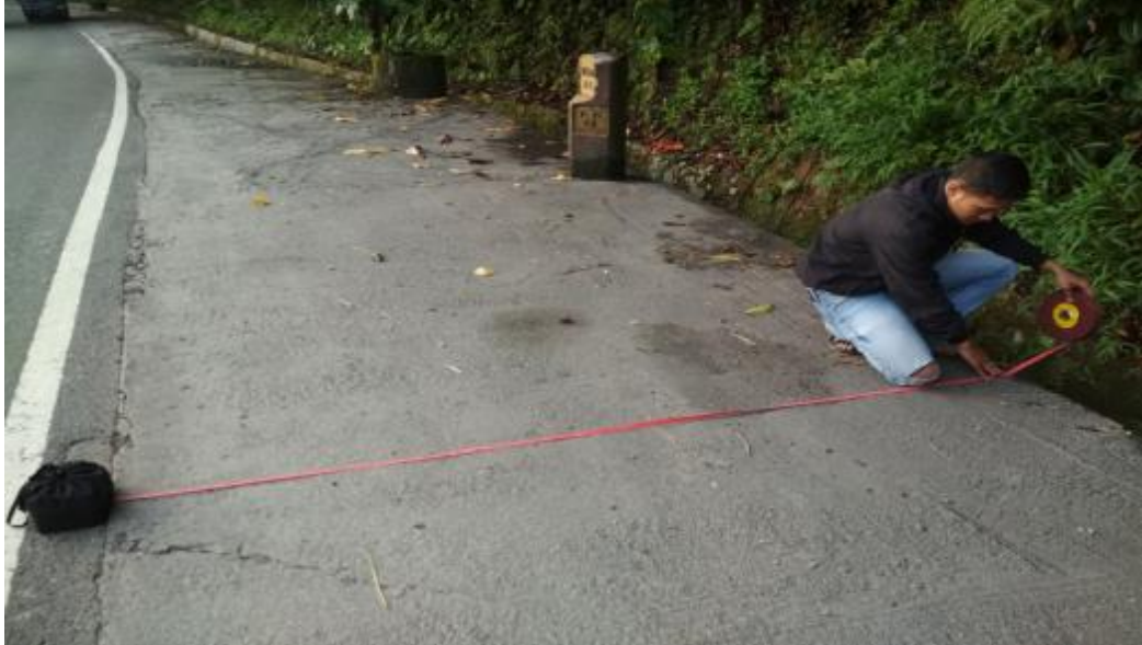
Gambar 5.1 :Dokumentasi pengukuran bahu jalan pada lokasi survey
