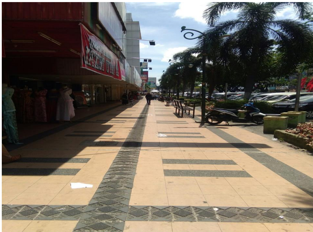
Gambar L2: Kondisi eksisting geometri jalan.
