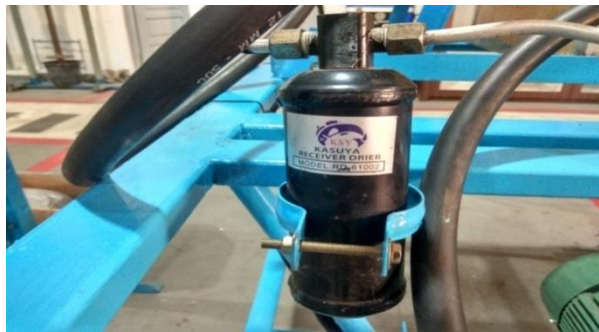
Gambar 3.5 Receiver Dryer Sebagai penyaring
