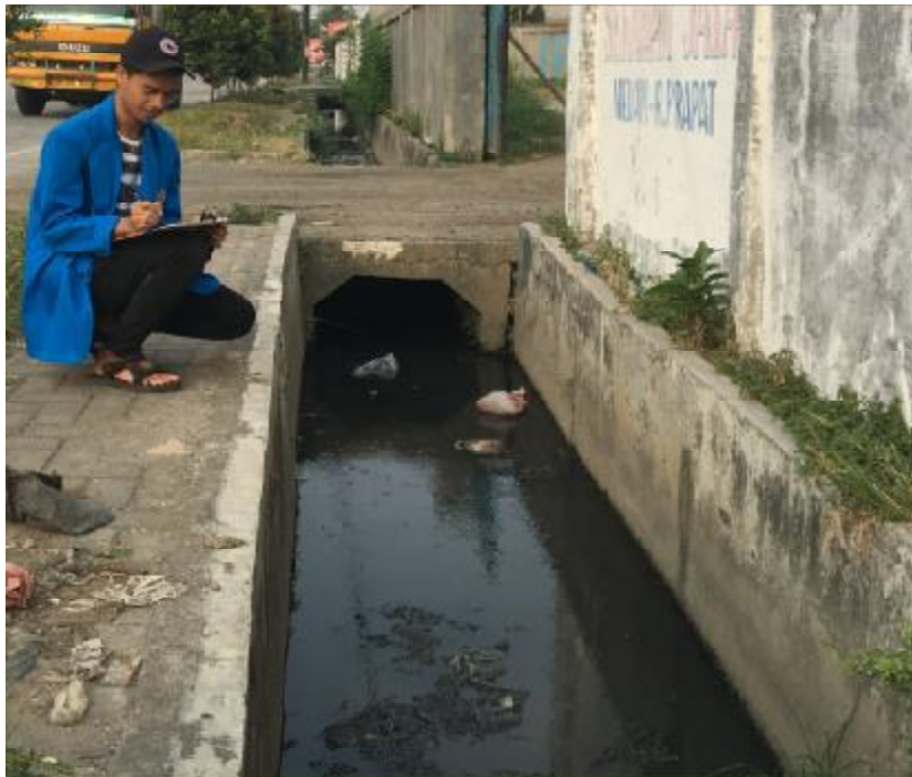
Gambar L.3: Mencatat lebar drainase.
