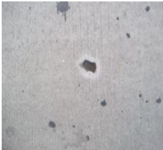
Gambar 3.6: Pelepasan butir agregat.
