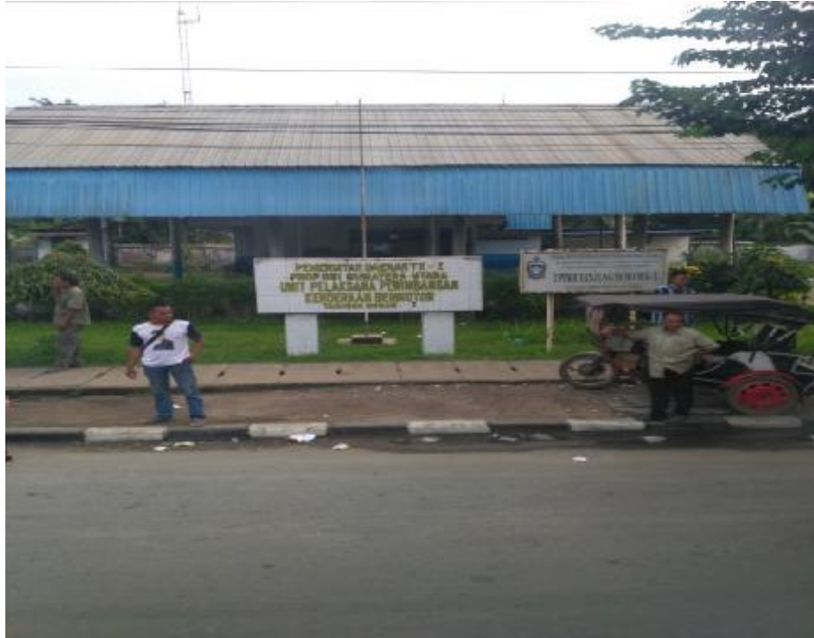
Gambar L.5: UPPKB yang tidak beroperasi.
