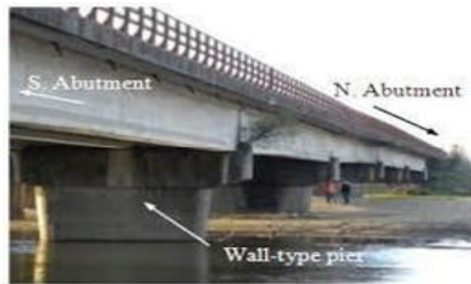
Gambar 2.3: Pilar tipe berdinding penuh pada jembatan (Fadhilah, 2012).
