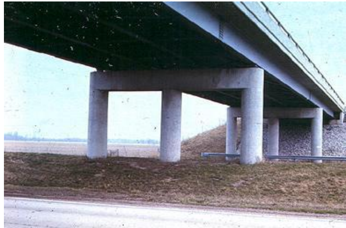
Gambar 2.1: Multi-Column Pier di jalur antar kota (Fadhilah, 2012).
