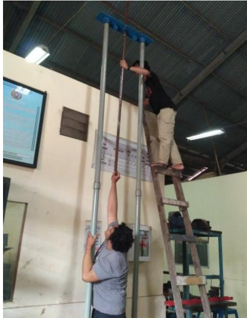
Gambar 3.13 Pemasangan besi baja karbon
