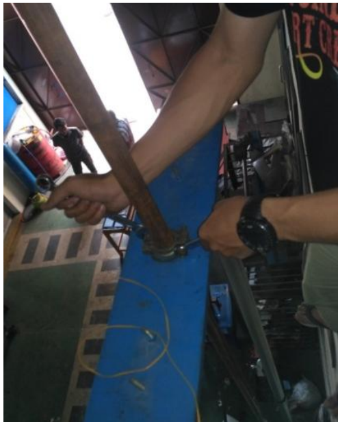
Gambar 3.14 Pemasangan klem besi
