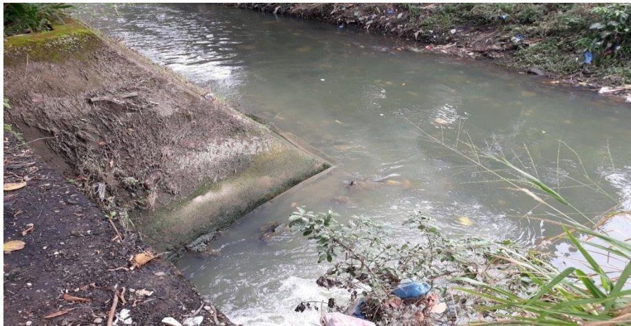
Gambar 3.5: Gambar kondisi saluran primer.
