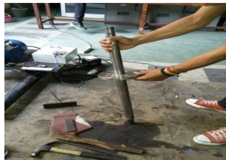
Gambar 3.14. Pemasangan Flange Dan Cakram
