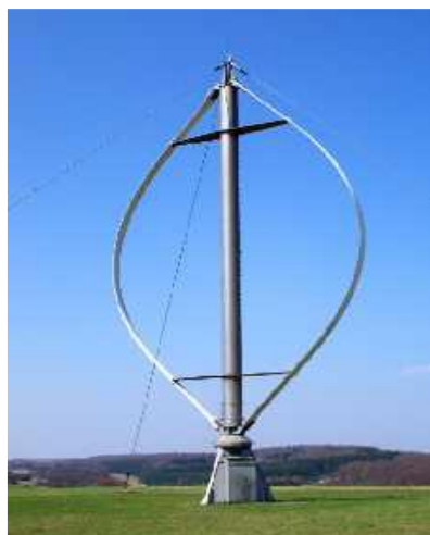
Gambar: 2.10 Turbin Angin Jenis Derrieus
