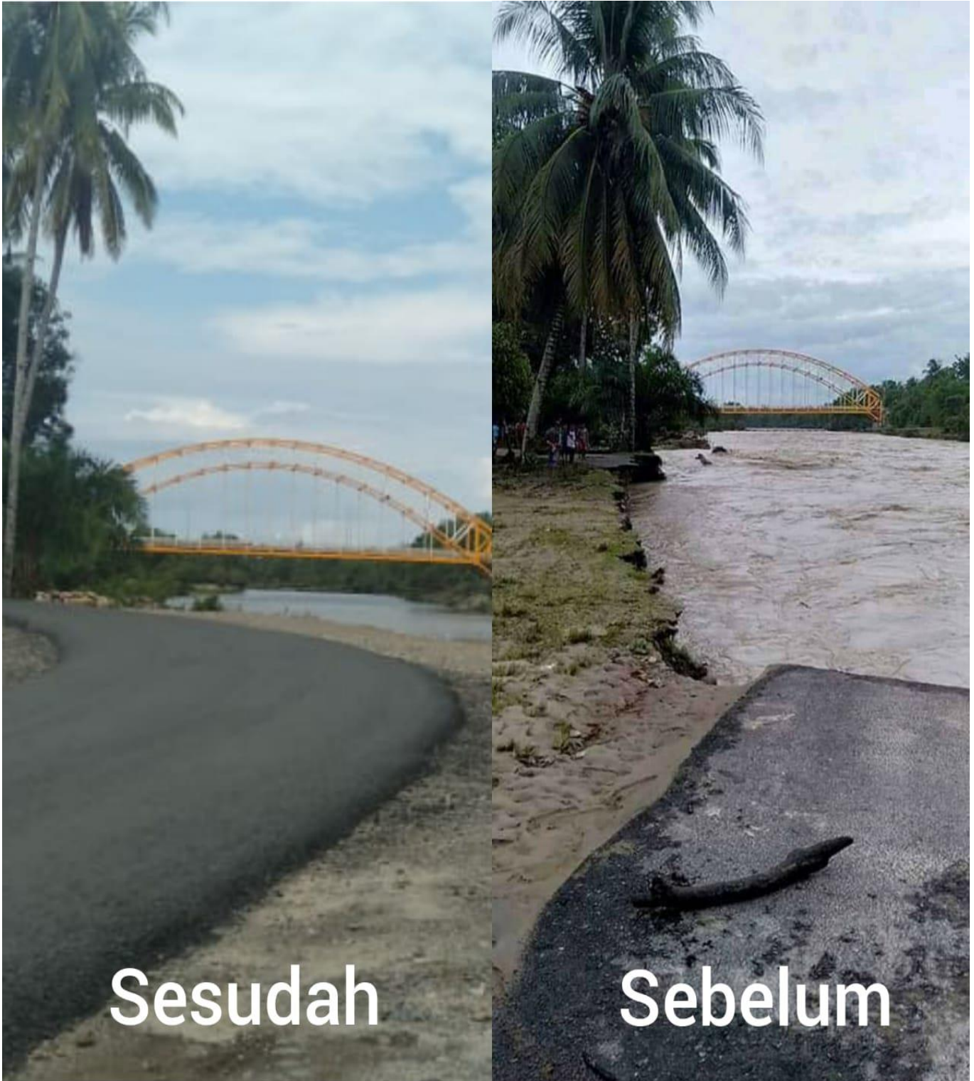
Gambar : Sebelum dan Sesudah Rekonstruksi
