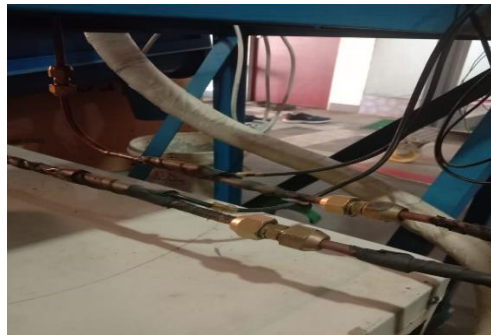
Gambar 4.24. Sensor Suhu Masuk Kondensor
