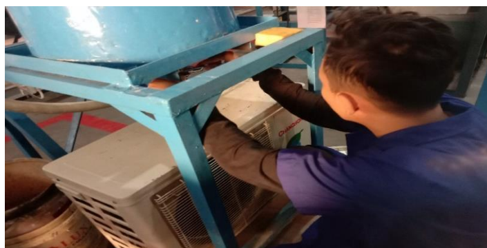
Gambar 4.12. Penyambungan Alat Penukar Kalor ke Jalur Refrigerant
