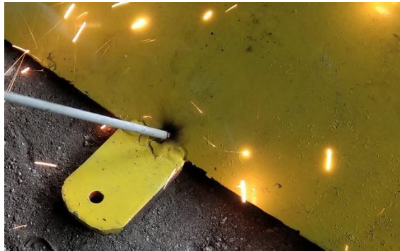
Gambar 4.42. Pengelasan Plat Pengikat Kejalan
