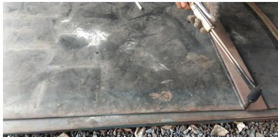
Gambar 4.39. Pemotongan Bahan
