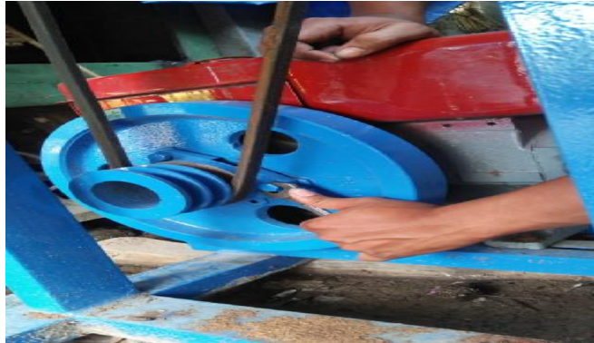
Gambar 4.3. Pemasangan Puli 4 inchi
