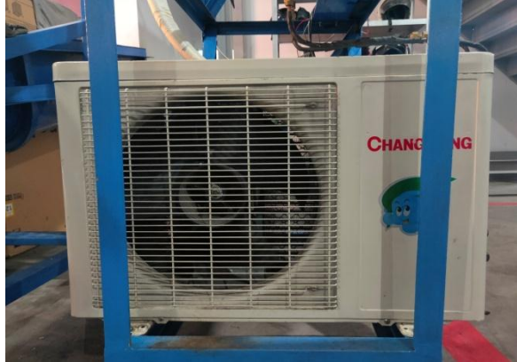
Gambar 3.8 Kondensor AC
