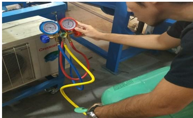
Gambar 3.35 Pengisian Freon Pada Sistem AC
