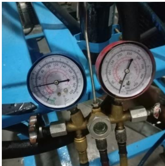
Gambar 4.19 Mengecek tekanan pada manifold gauge
