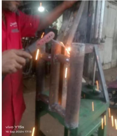
Gambar 4. 14 Penyambungan tabung las ke rangka hidrolik
