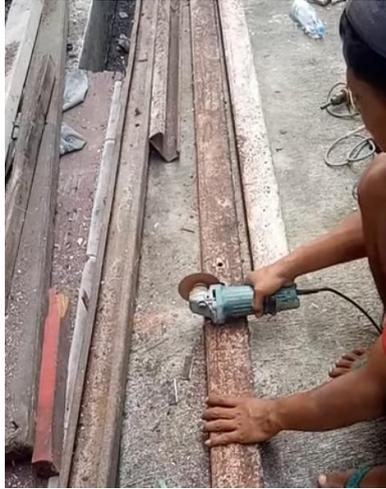
Gambar 4. 7 Proses pemotongan besi unp
