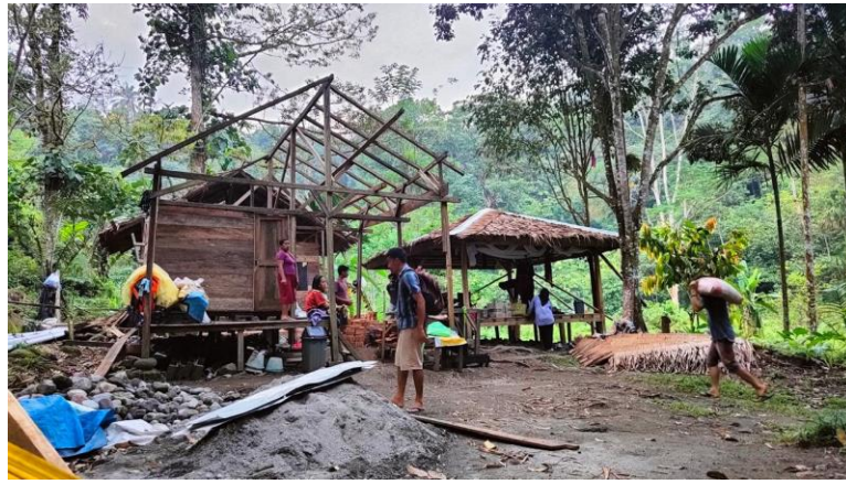
Gambar 4. 3 Pembangunan dan perbaikan infrastruktur
