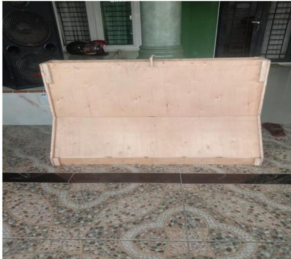
Gambar 4.1 Cetakan *Road barrier*
