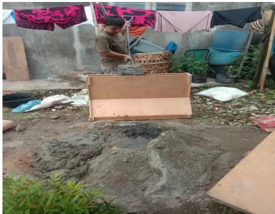
Gambar 4.4 Proses Memasukan Bahan Ke Dalam Cetakan
