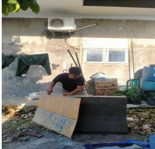
Gambar 4.5 Proses Pembukaan Hasil Cetakan
