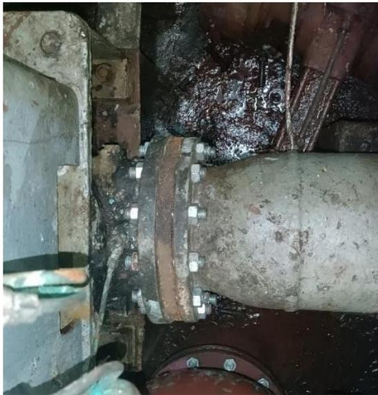
Gambar 4.2 Kebocoran Pada Pipa Pendingin Air Tawar
