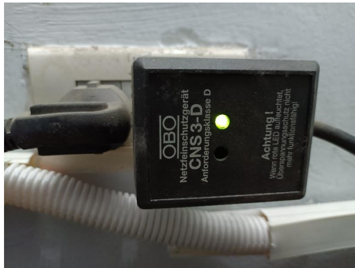
Gambar 4.12. Arrester komputer display ASRS
