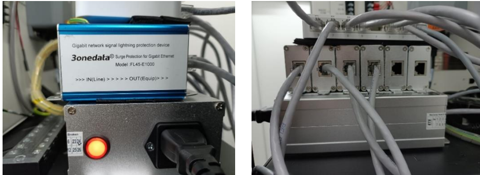
Gambar 4.3. LAN arrester Particulat Matter 2,5
