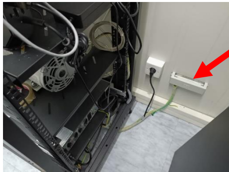
Gambar 4.4. Pentanahan pada Particulat Matter 2,5
