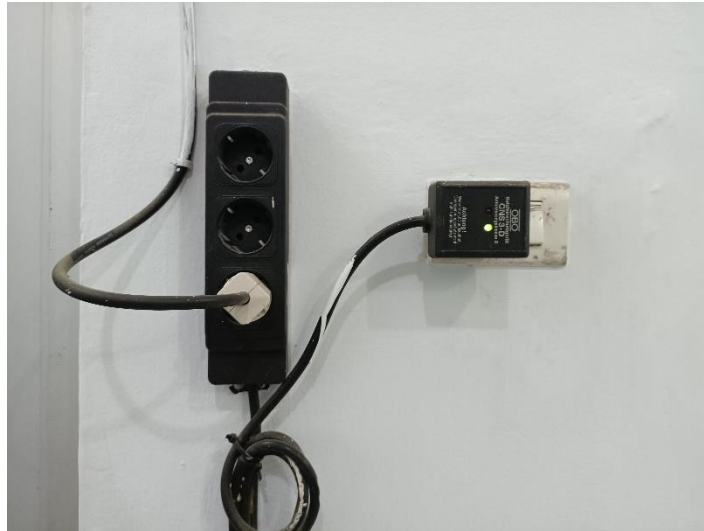
Gambar 4.10. Arrester display AWS
