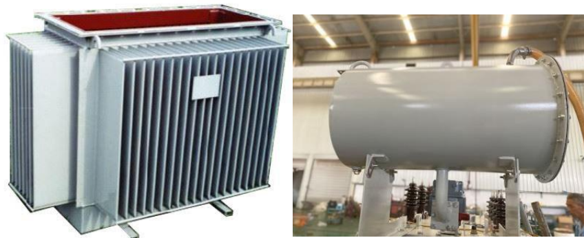
Gambar 2.7 Tangki dan Konservator Transformator
