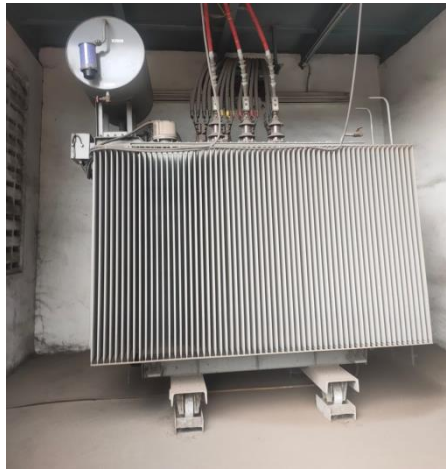
Gambar 3.2 Trafo 3500 kVA
