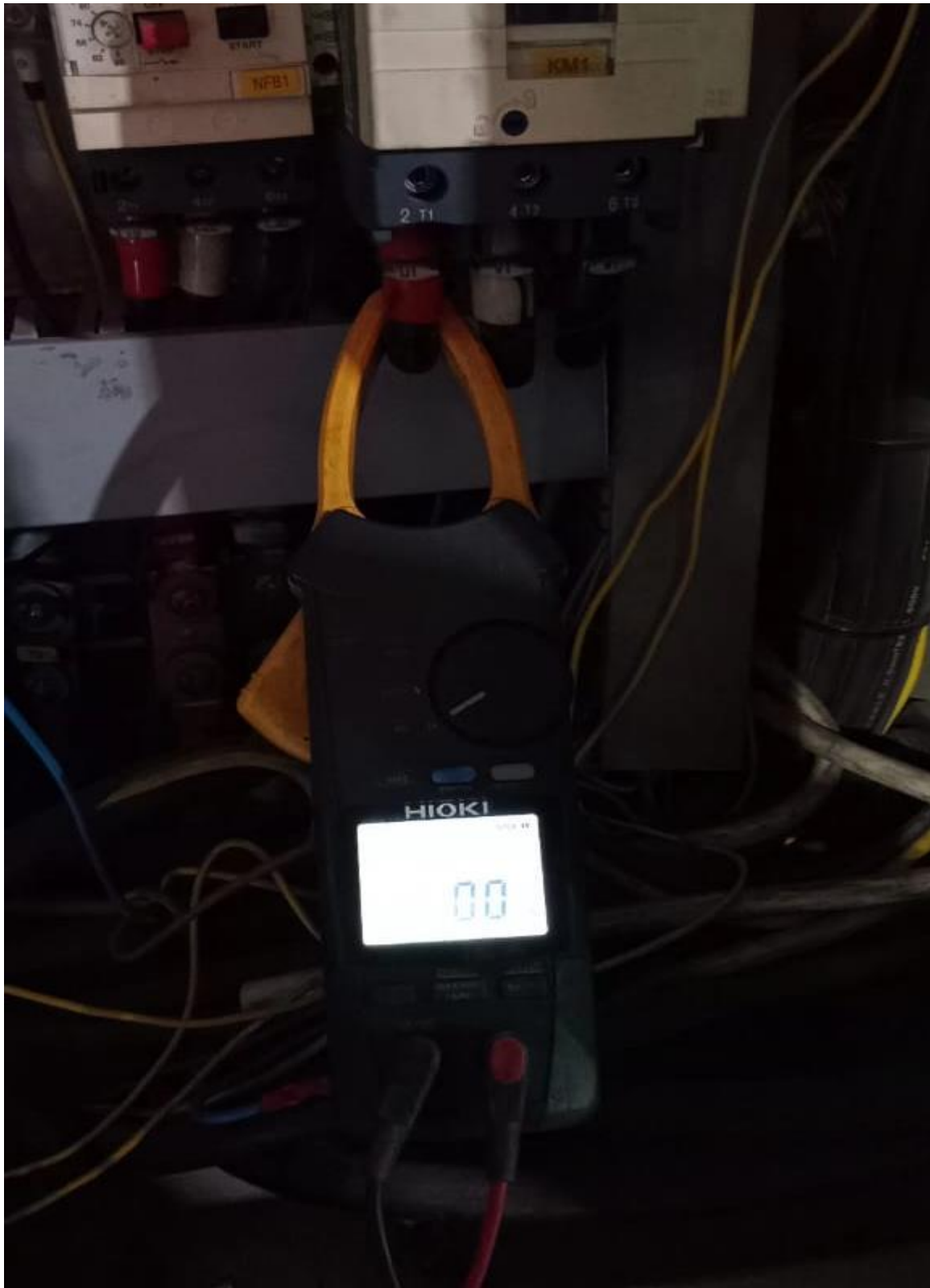
Gambar 4.5 Pengukuran pada motor hidrolik (tidak bekerja)
