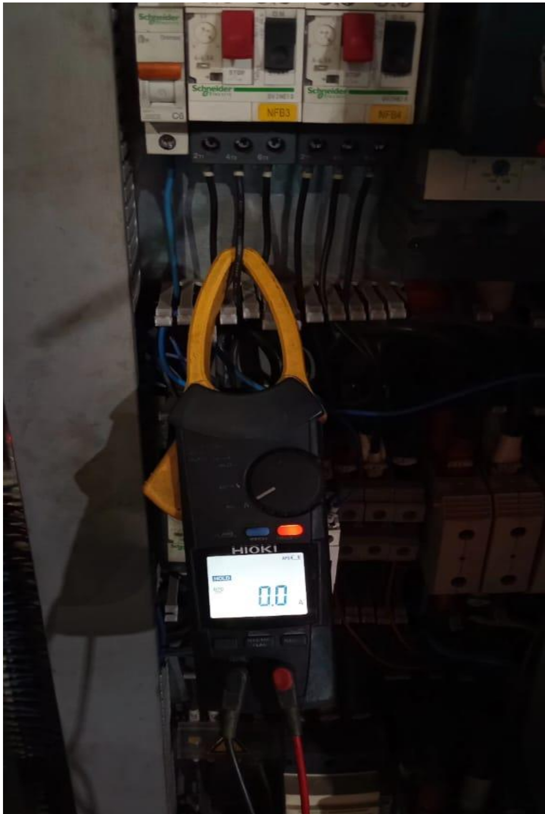
Gambar 4.6 Pengukuran pada Arus Utama (Tidak Bekerja) Pada Mesin 3000 T.
