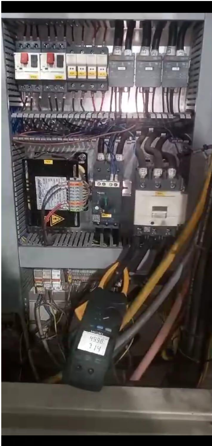
Gambar 4.2 Kondisi Saat Hidrolik Push ke Atas Pada Mesin 3600
