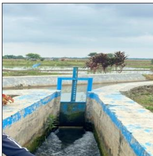
Gambar 4. 2 Pintu Masuk Air Irigasi
