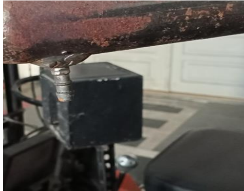
Gambar 4.15. pemasangan nipple ex pada kondenso
