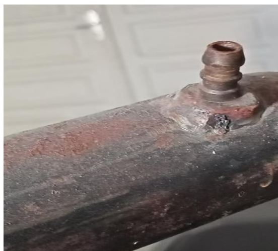
Gambar 4.14. proses pemasangan nipple in
