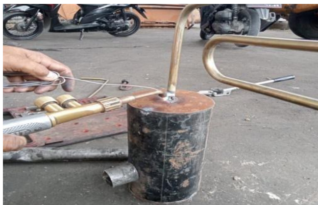
Gambar 4.12. Proses pengelasan pipa penghubung
