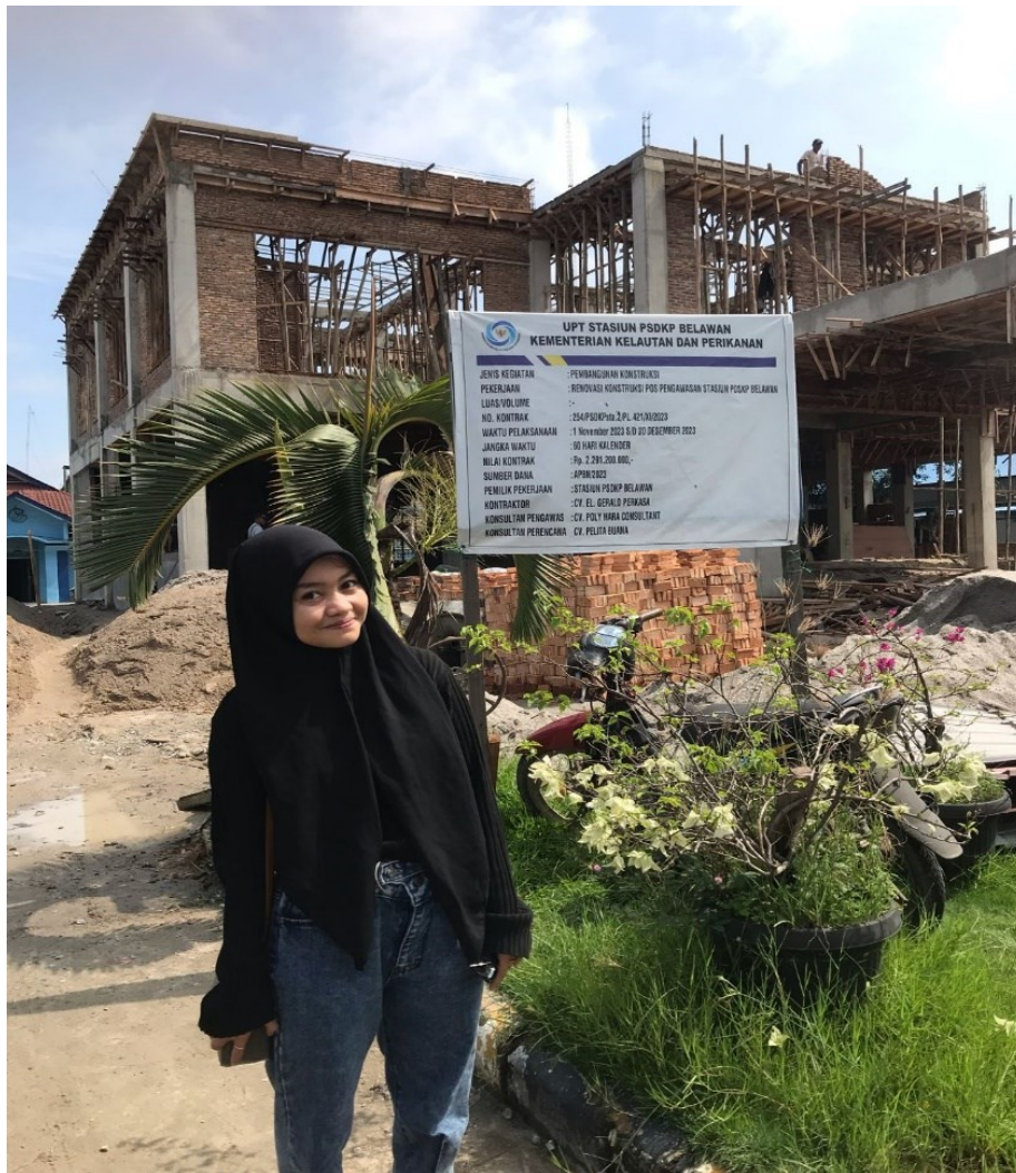
UPT Stasiun PSDKP Belawan yang masih dalam proses pembangunan
