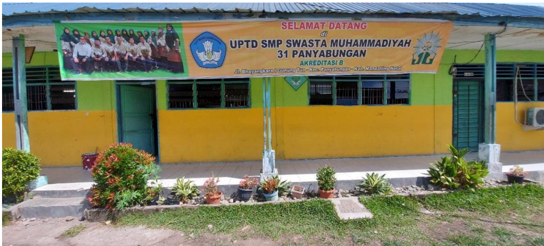
Gambar 6 Penampakan Luar bangunan SMP Muhammadiyah 31 Panyabungan
