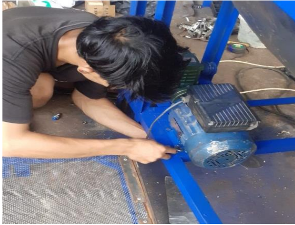
Gambar 4.27 Pemasangan motor listrik
