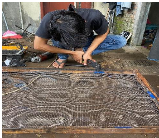
Gambar 4.12 Proses pemasangan jaring ayakan
