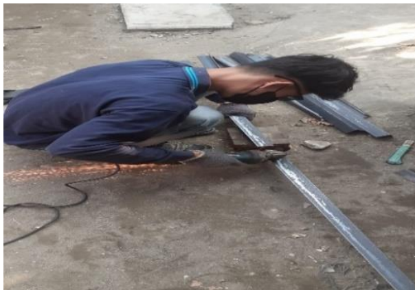
Gambar 4.3 Proses Pemotongan Besi Siku untuk rangka
