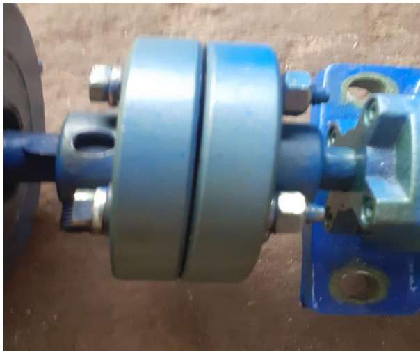
Gambar 4.28 Pemasangan fcl kopling
